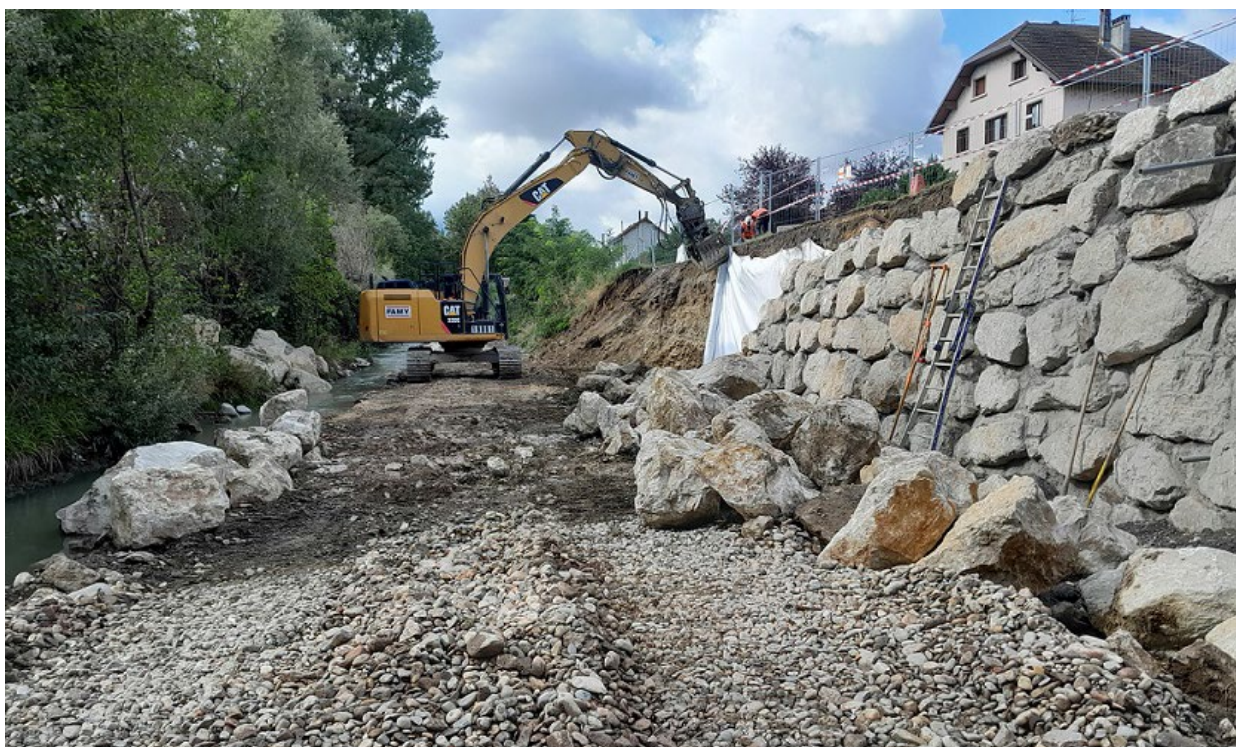
Confortement de digue à Chambéry (Savoie) © CISALB, sd
